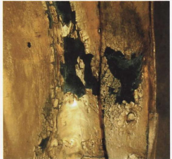
Stützen waren zu großen Teilen durch Korrosion abgemagert, an den Nietverbindungen mit der Kupferhaut war das Eisen durch Kontaktkorrosion zerstört. Die äußere Stützkonstruktion konnte bei der Restaurierung erhalten werden.
